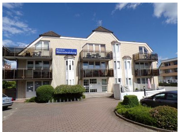
Deschlagshöfchen im Haus II
