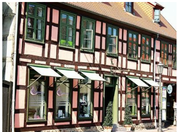
liebevoll restauriertes Fachwerkhaus
