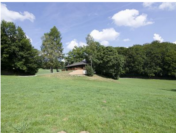
Außenansicht Ferienhaus Mondschein
