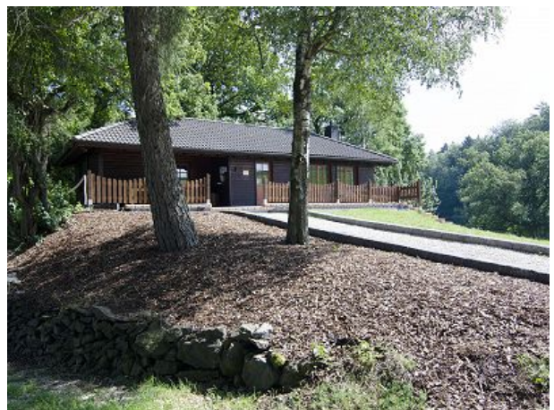
Außenansicht Ferienhaus Mondschein
