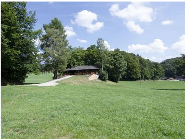
Außenansicht Ferienhaus Mondschein
