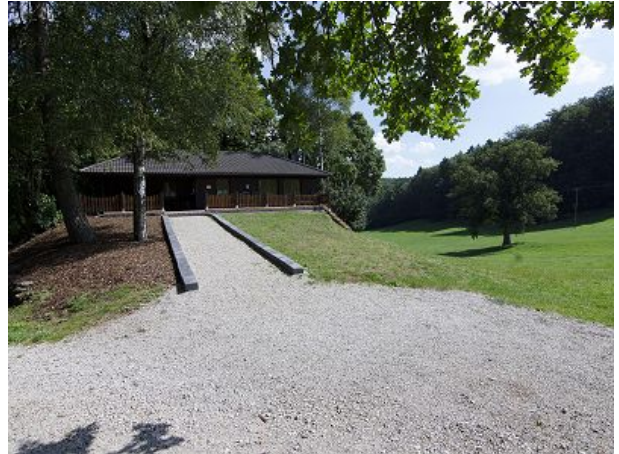
Zugang zum Ferienhaus
