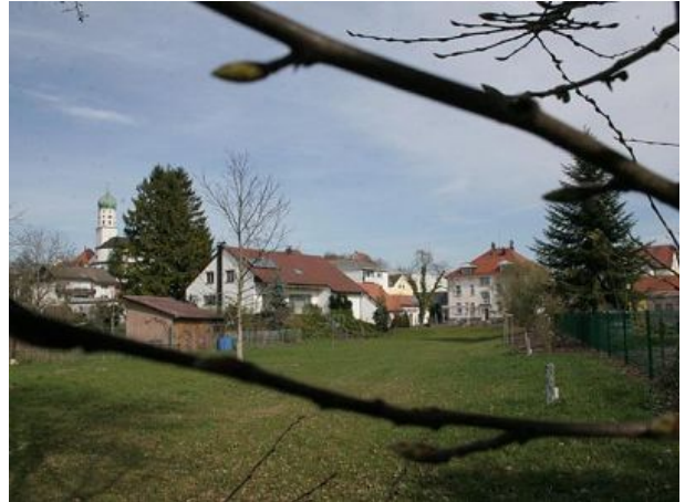
Ansicht Südseite vom Garten aus
