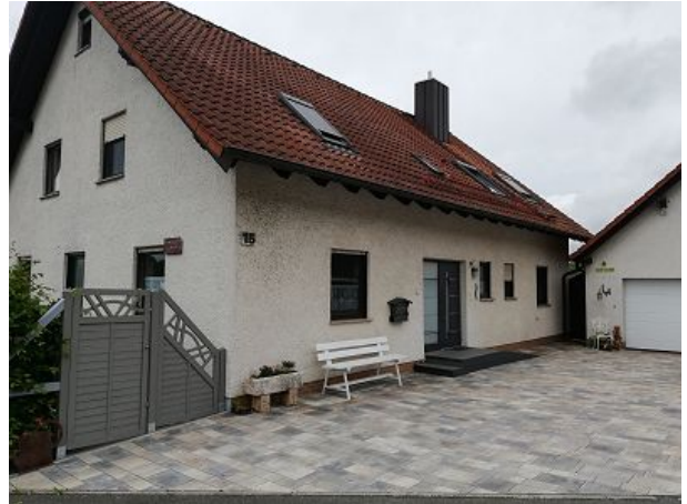
Hausansicht mit Eingang
