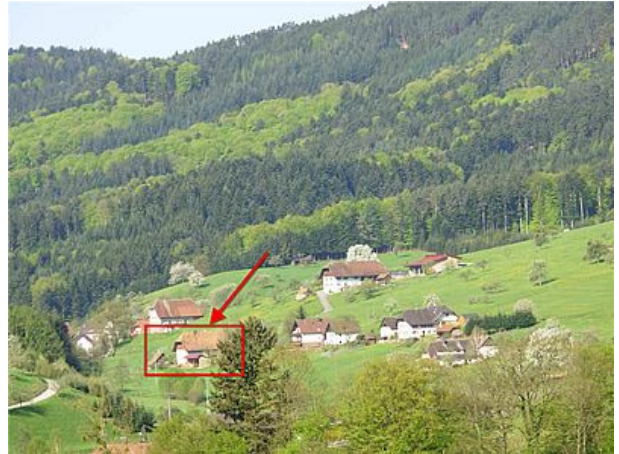
Haus im Regelsbachtal
