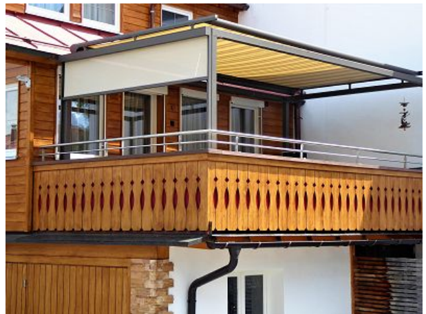
Dachterrasse mit Markise
